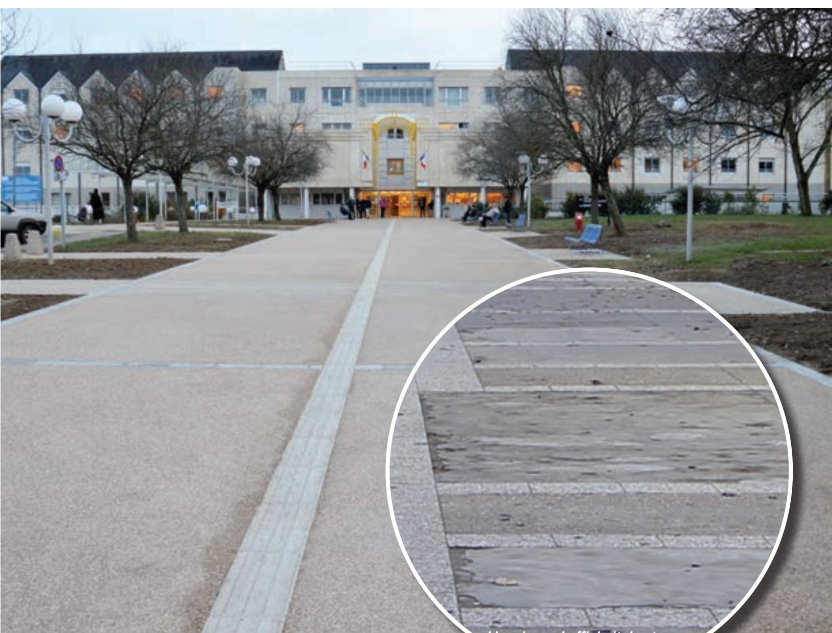
L'ancien sol affichait des traces d'usures prononcées
